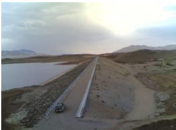
سد شهید قنبری ماکو در حال بهره‌برداری در استان آذربایجان غربی به حجم مخزن 26/5 میلیون مترمکعب و ارتفاع 24/0 متر
