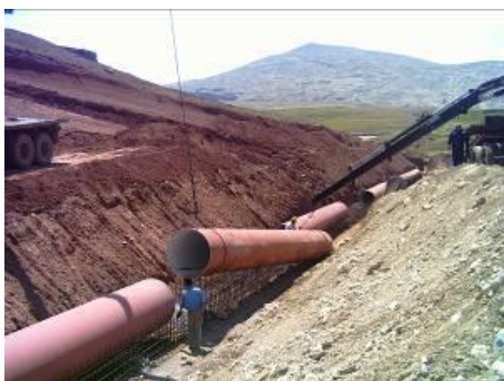
اجرای لوله انحراف و آبگیر سد دانالوی ماکو در استان آذربایجان غربی به ارتفاع 23/0 متر (هم‌اکنون در حال بهره‌برداری)
