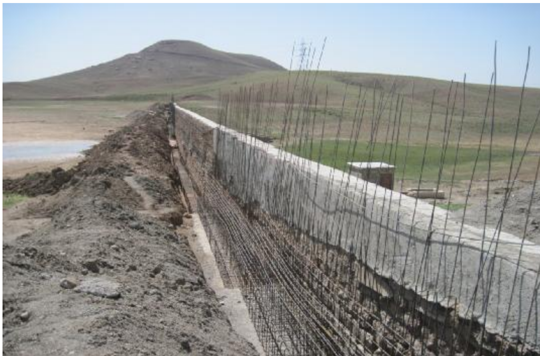
اجرای دیواره آبنند بتنی سد خرمالوی اهر
