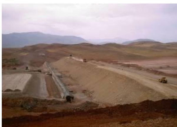
سد شهید قنبری ماکو در حال ساخت در استان آذربایجان غربی به حجم مخزن 26/5 میلیون مترمکعب و ارتفاع 24/0 متر
