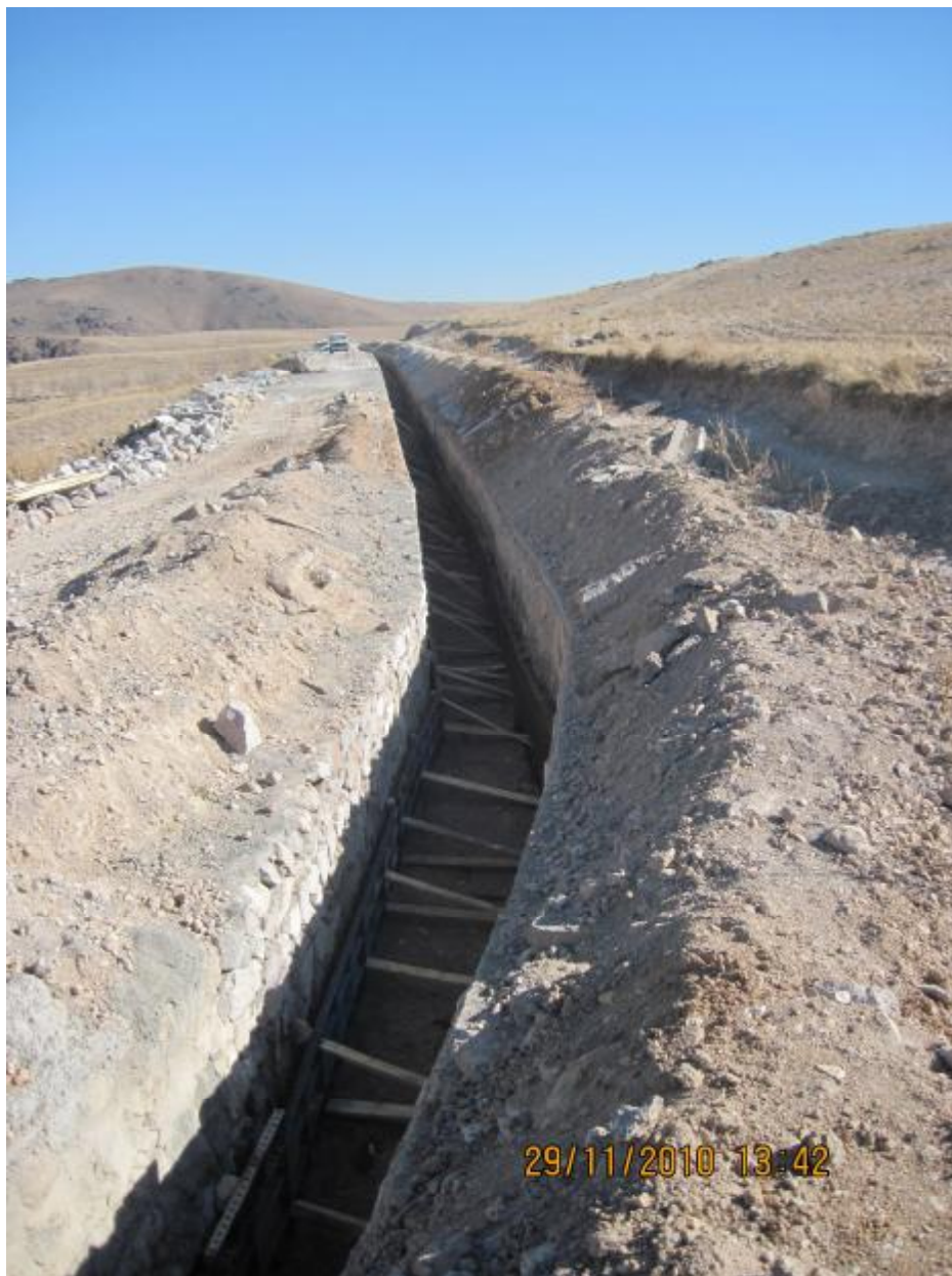
اصلاح شیب کف کانال و پانل گذاری بر روی آن در مسیر انتقال آب در محدوده روستای هراب
