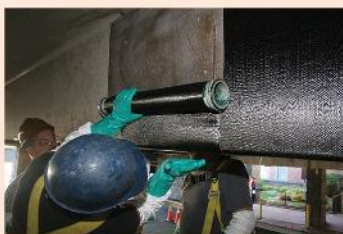
▲ FRP Sheet Wrapping
